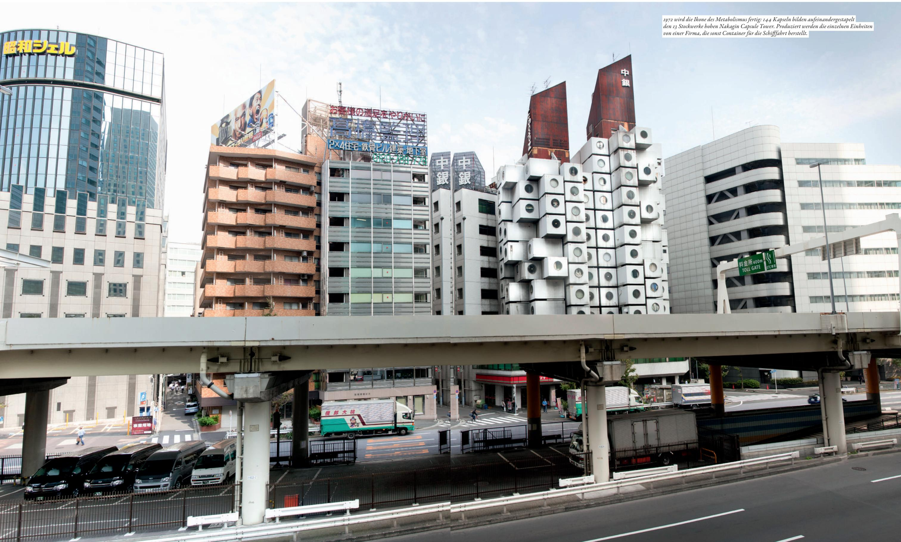
1972 wird die Ikone des Metabolismus fertig: 144 Kapseln bilden aufeinandergestapelt den 13 Stockwerke hohen Nakagin Capsule Tower. Produziert werden die einzelnen Einheiten von einer Firma, die sonst Container für die Schifffahrt herstellt.
